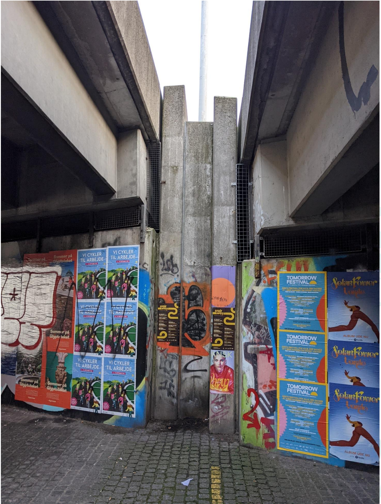
To separate vejbroer samles i en delvist sammenbygget rampe. Den ene kan tages ned, samtidig med at den anden bliver stående // eget foto
